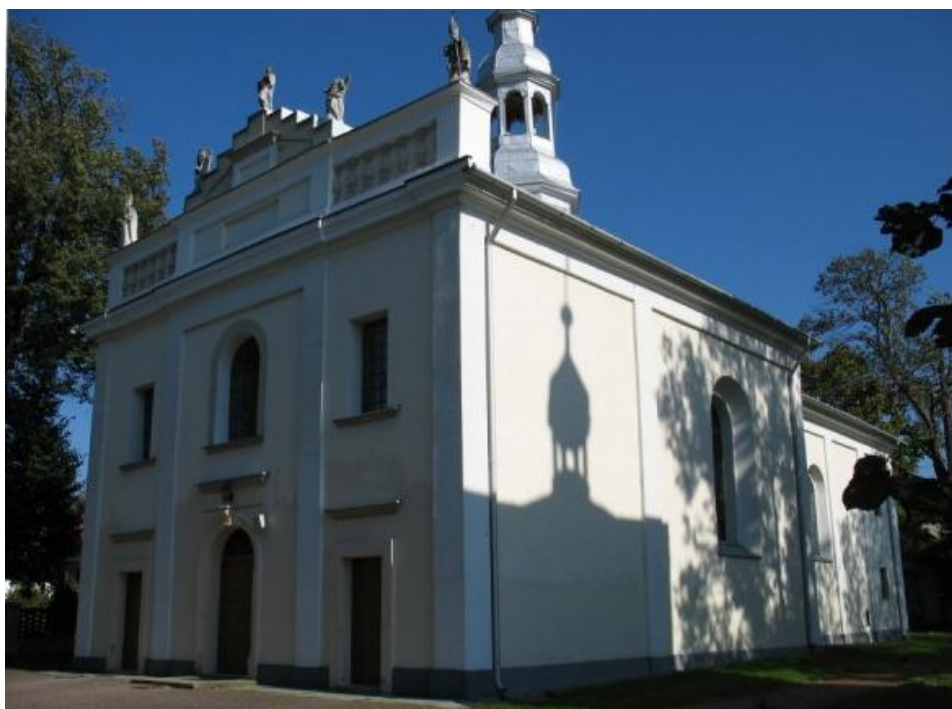
Zdjęcie 8. Kościół św. Marcina w miejscowości Wrocieryż.
